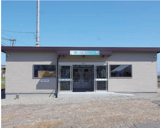
新設したコインランドリー
