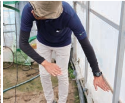
トマトのハウスがここまで浸かりました(郡築)
