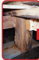
束柱の被害
